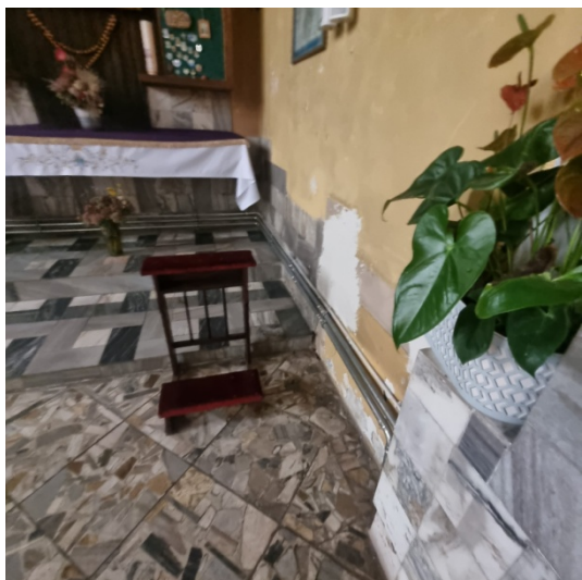
Fot. 3 Widoczne rurki instalacji grzewczej
