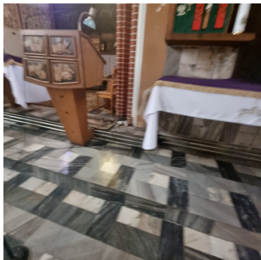
Fot. 2 Widoczne rurki instalacji grzewczej
