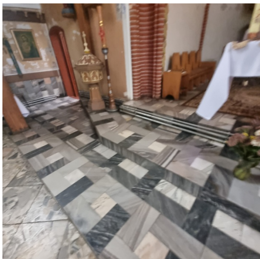
Fot. 1 Widoczne rurki instalacji grzewczej
