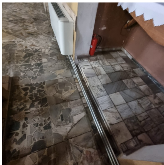
Fot. 4 Widoczne rurki instalacji grzewczej
