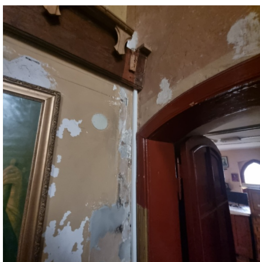
Fot. 7 Widoczne plastikowe maskownice instalacji elektrycznej
