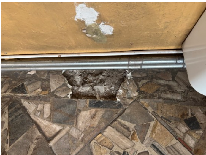
Fot.21 Próba skucia posadzki – miejsce planowanego prowadzenia rur grzewczych.
