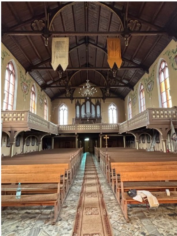
Fot.6 Ujęcie z prezbiterium w stronę nawy – widoczna empora organowa, układ okien oraz kamienna posadzka.
