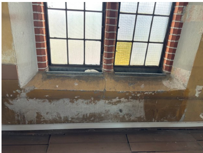
Fot. 13 Kruchta pod wieżą – zniszczone dolne partie ścian. Rozległe odspojenia tynków powstałe w wyniku długoletniego zawilgocenia spowodowanego gromadzeniem się wody przy murach i brakiem odpływu.
