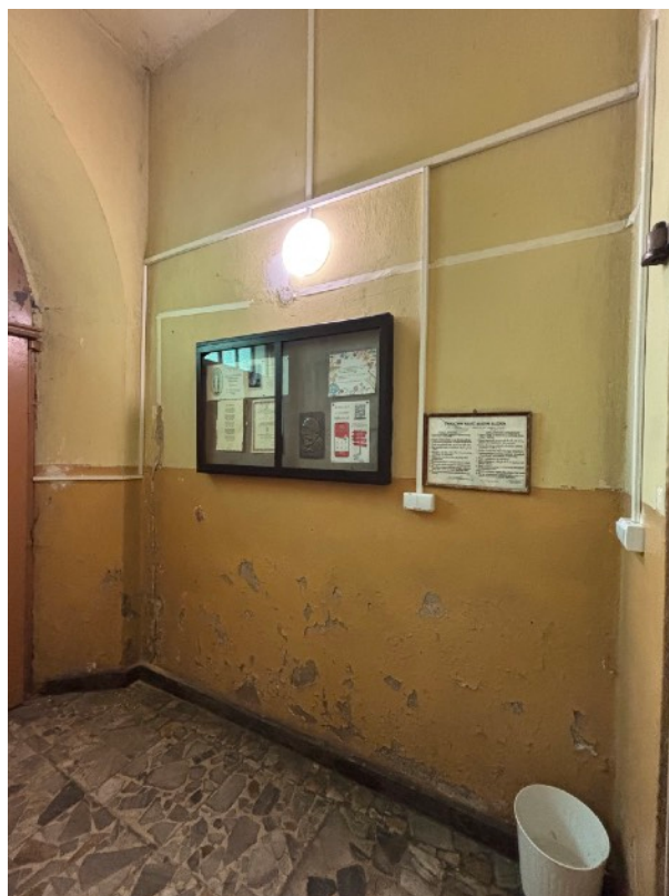
Fot. 13 Kruchta pod wieżą – zniszczone dolne partie ścian. Rozległe odspojenia tynków powstałe w wyniku długoletniego zawilgocenia spowodowanego gromadzeniem się wody przy murach i brakiem odpływu.
